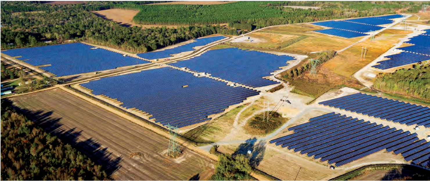
27,4 MWp Photovoltaikkraftwerk in Hazlehurst, Georgia, USA, 2015 gebaut im Auftrag der Silicon Ranch Corporation
